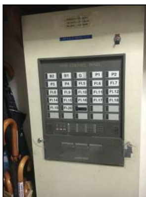
ภาพที่ 1-9 แผงควบคุมไฟอะลาม (Fire Alarm Control Panel)
