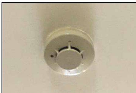
ภาพที่ 1-10 อุปกรณ์ตรวจจับควันและความร้อน (Smoke and Heat Detector)
